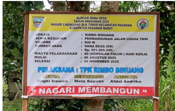
Gambar 1. Proyek Pembangunan Jalan Usaha Tani di Rimbo Binuang
