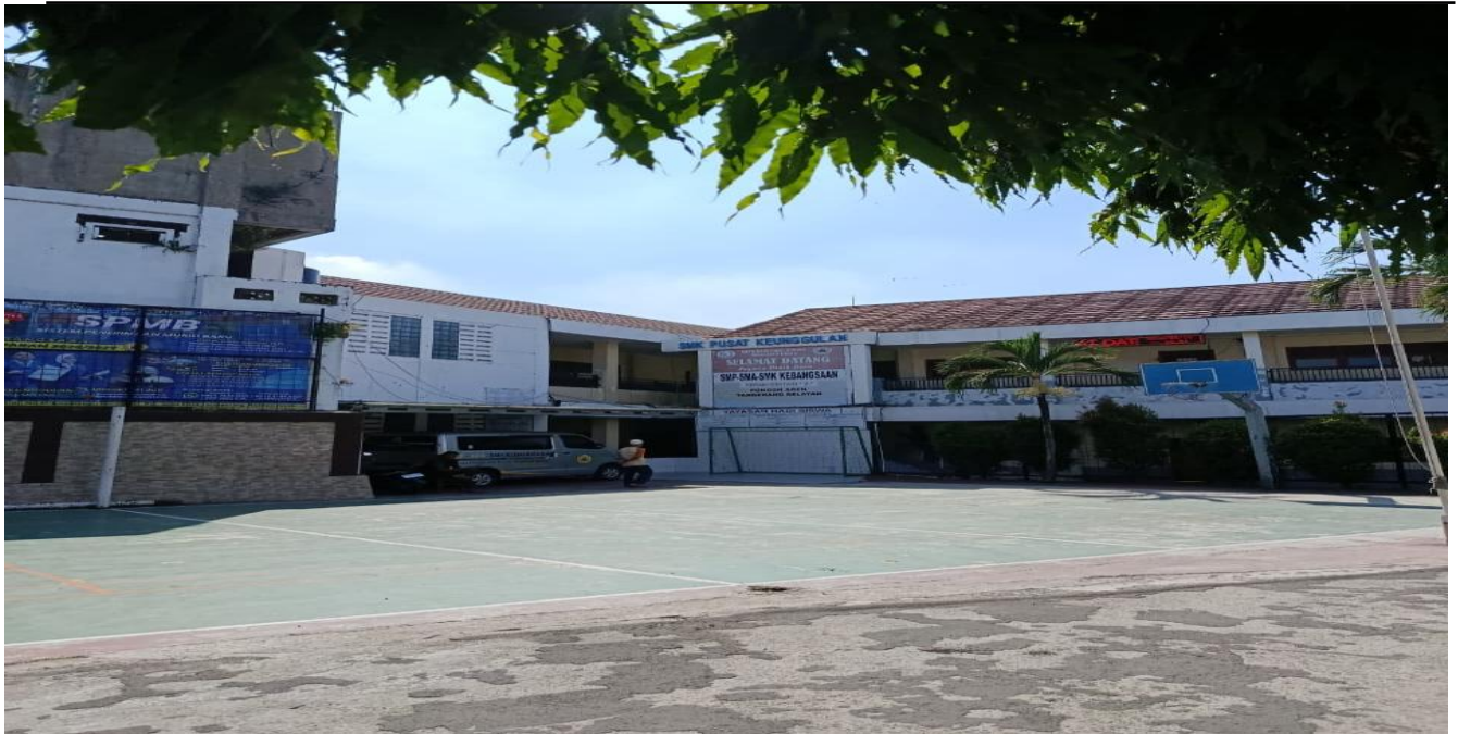
[Gambar 4.1 Kondisi Lingkungan dan Gedung SMA Kebangsaan Kota Tangerang Selatan]
